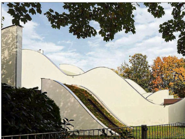
Die Debatte um die Kita Wintersteinstraße gleicht einem ewigen Auf und Ab: Neubau oder doch Sanierung? (Foto: Nici Merz)
