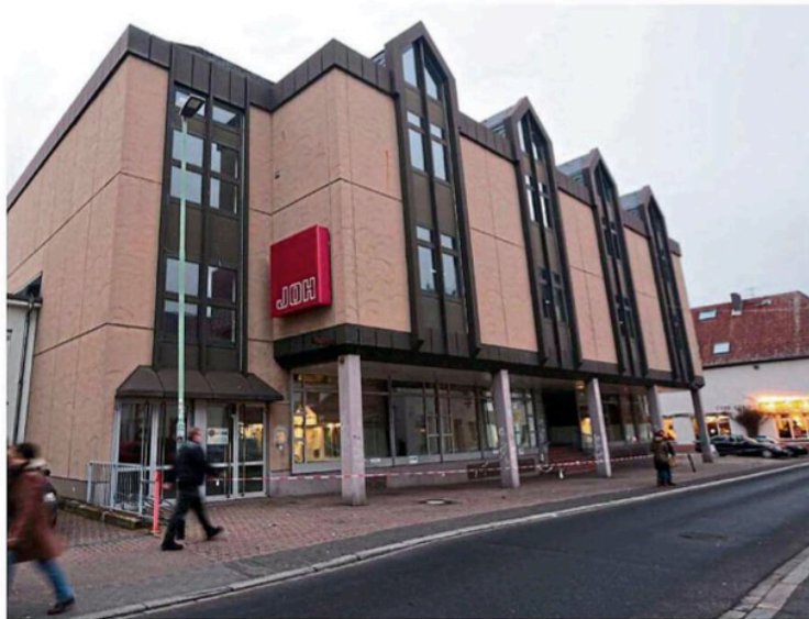
Die Rückseite des Kaufhauses Joh in der Färbergasse: Zwischenzeitlich war hier eine Rampe geplant, um das Kellergeschoss als Tiefgarage zu nutzen. Das ist Schnee von gestern. FOTO: NICO MERZ
